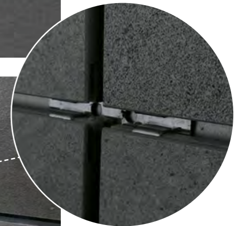
SISTEMA A SCOMPARSA Hidden anchor system Système non apparent Unsichtbare Befestigung Sistema oculto Скрытая система
