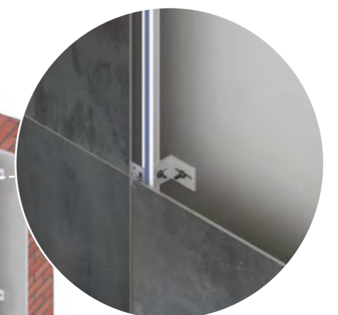
SISTEMA INCOLLATO Glued anchor system Système collé Befestigung durch Klebung Sistema encolado Наклеиваемая система
